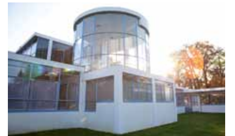
De architecten Hubert-Jan Henket (hierboven) en Wessel de Jonge namen samen de restauratie van Sanatorium Zonnestraal onder hun hoede. Het gebouw van Jan Duiker (1890-1935) is een geslaagde fusie van beton met rafijne raamsponningen en veel glas.
